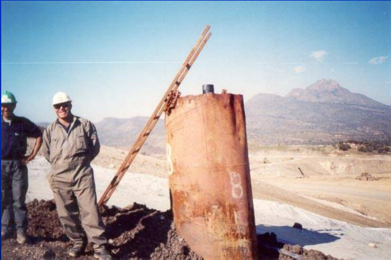
Landfill Gas Vents
